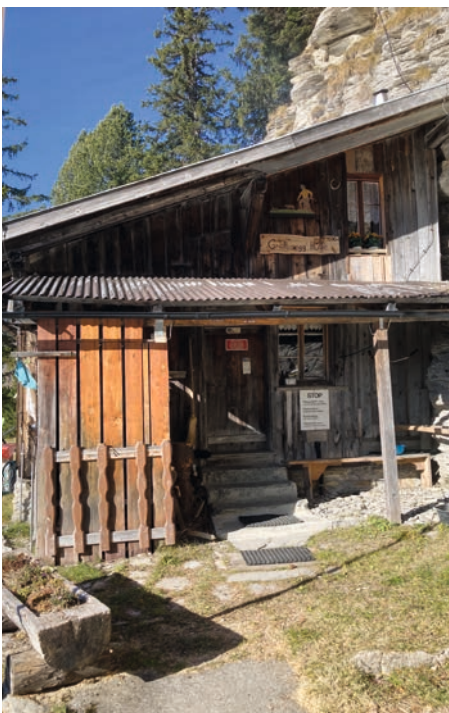
Grätlisegghütte, Unterkunft der Verbauungsequipe, Foto von 2024
