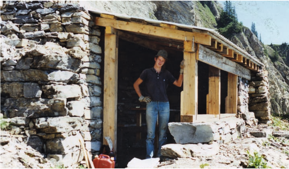
Das 1986 wiederaufgebaute Steinhittli, Foto von 1987
