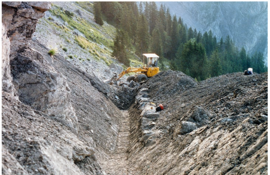
Wiederinstandstellung der Entwässerungsanlage untere Urseren, Foto von 1987
