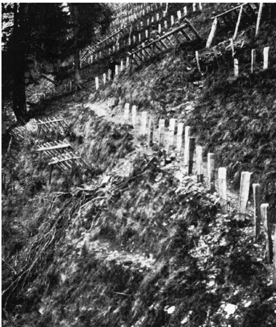
Lawinenverbauung, kleine Holzschneerechen und Verpfählungen mit Holz im Einzugsgebiet des Trachtbachs, Foto von 1913
