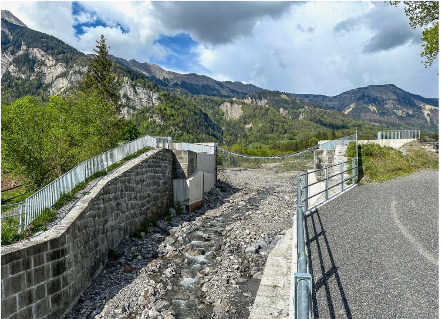
Das Abschlussbauwerk im Kienholz nach Abschluss der Fertigstellungsarbeiten
