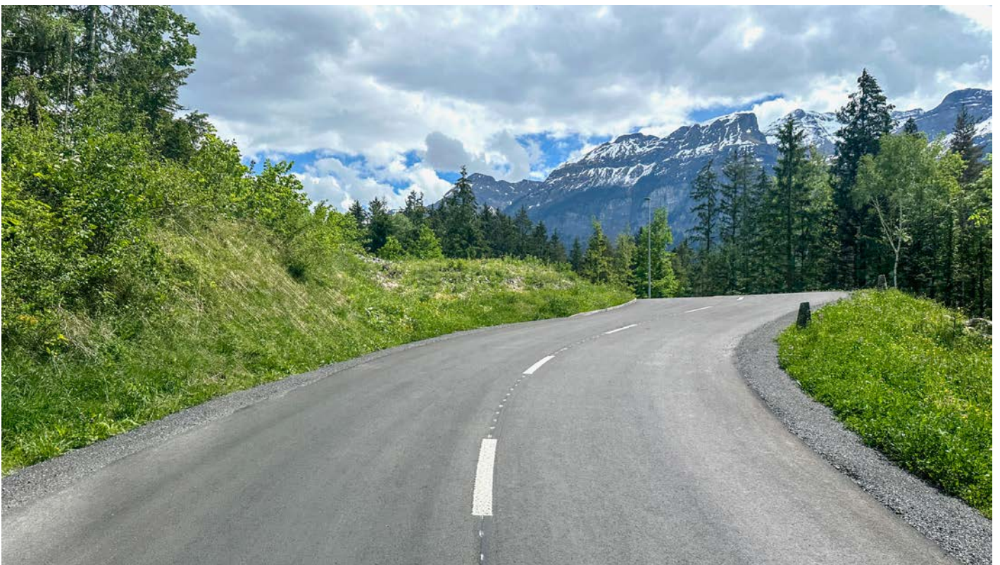
Die Oberschwanderstrasse nach Abschluss der Deckbelagsarbeiten
