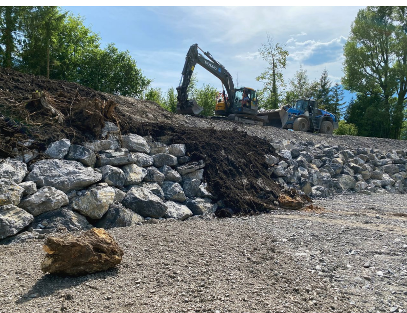
Dammschüttung mit Ufersicherung beim Geschiebesammler Kienholz
