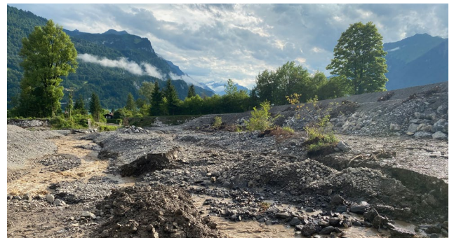
Schwanderbach-Ausuferungen im Bereich der Baustelle
