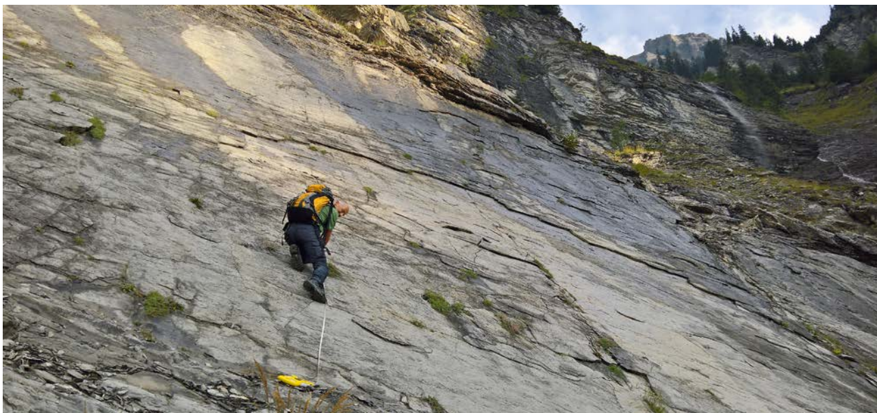
Mit Distanzmessungen überwacht René Mäder die Stabilität des Terrains.
