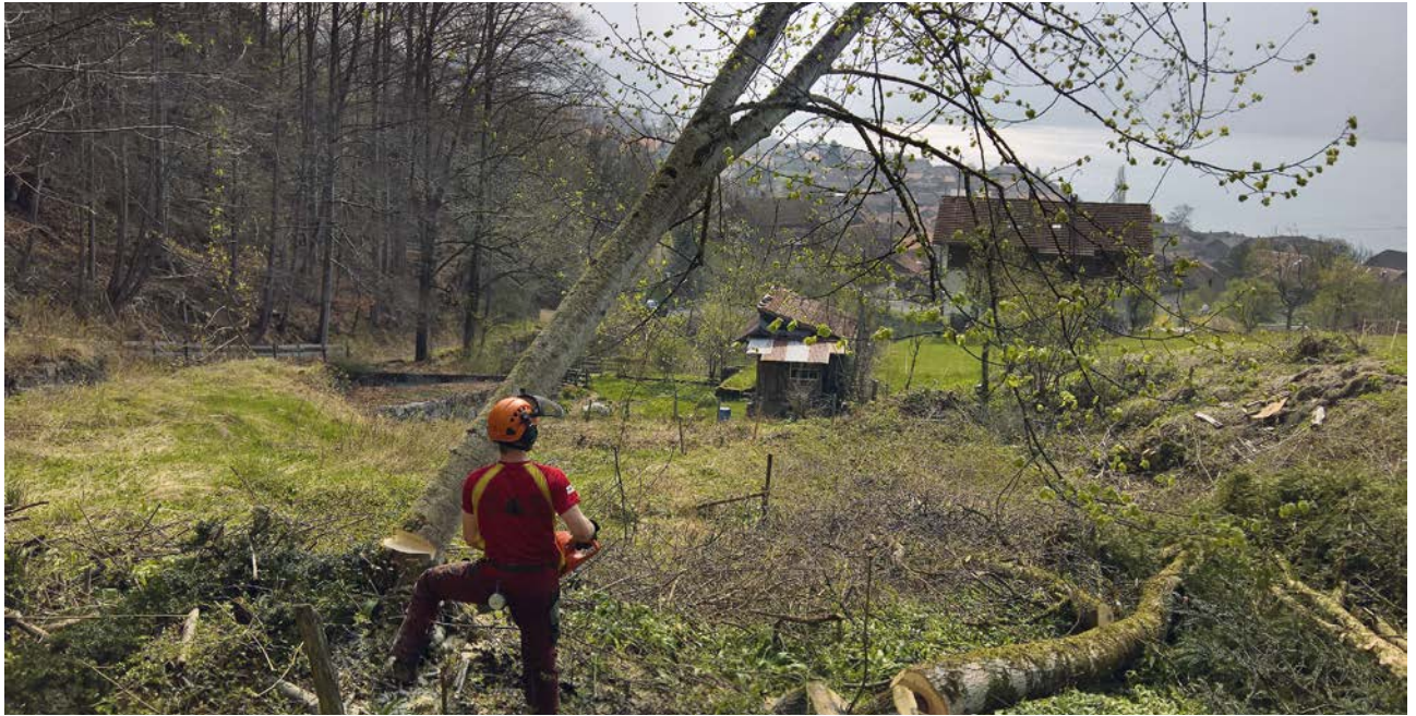
Im April hat der Forst Brienz den Projektperimeter gerodet.
