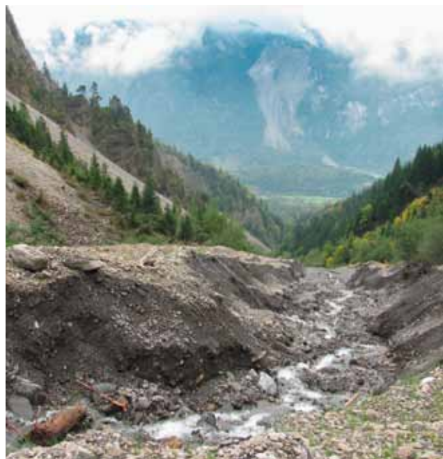
Hinter Sperre 4a lagern riesige Geschiebemengen.
