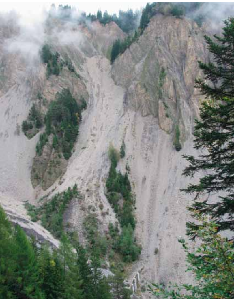
Blick von der Schwander Seite in den Lambachgraben Richtung Osten. In der Tiefe ist eine der Hauptsperren sichtbar.
