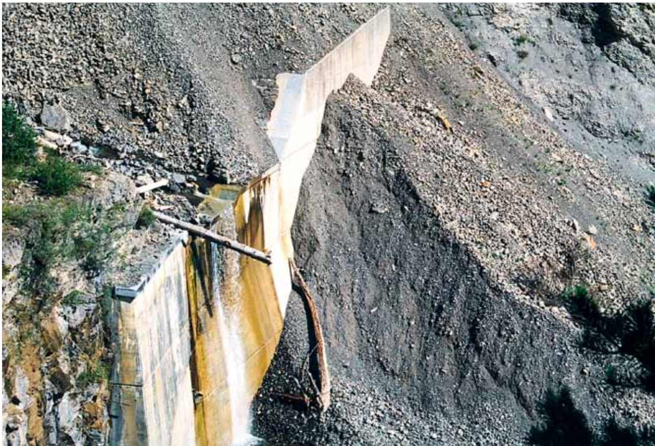
Sperre III, repariert und verstärkt mit einer verankerten Betonplatte
