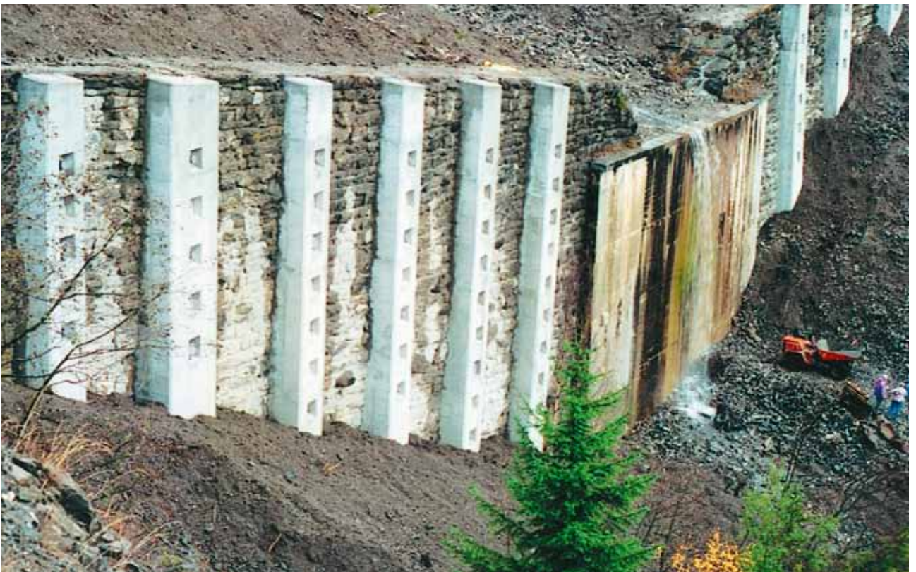
Oben Sperre IVa vor der Sanierung (die verankerte Betonplatte an der Mauer wurde 1977 gebaut), unten die gleiche Sperre nach der Sanierung im Jahr 2000 mit den zehn verankerten vertikalen Betonriegeln
