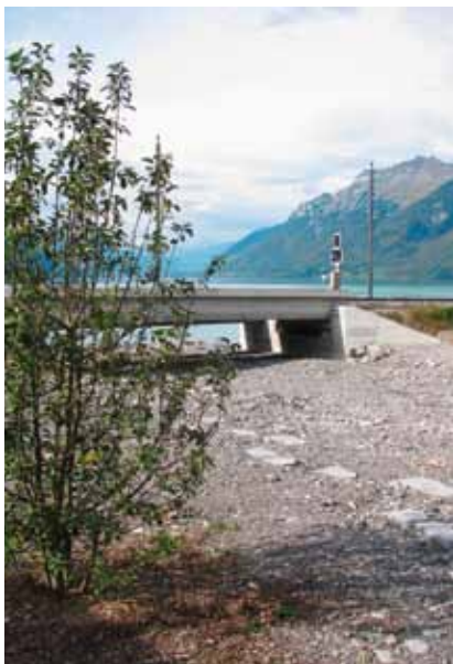
Zentralbahn-Brücke bei der Seemündung
