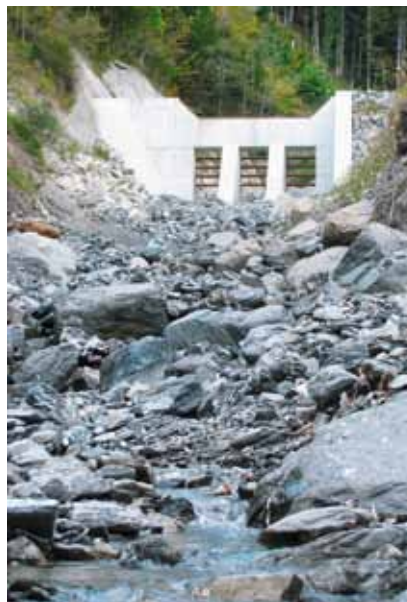
Das Ausleitbauwerk Glyssibach
