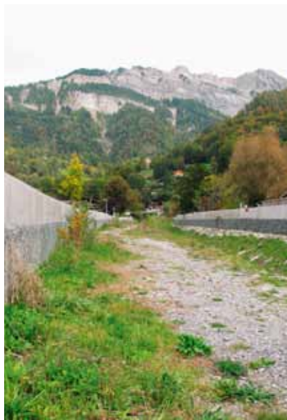
Neue Leitmauern am Trachtbach
