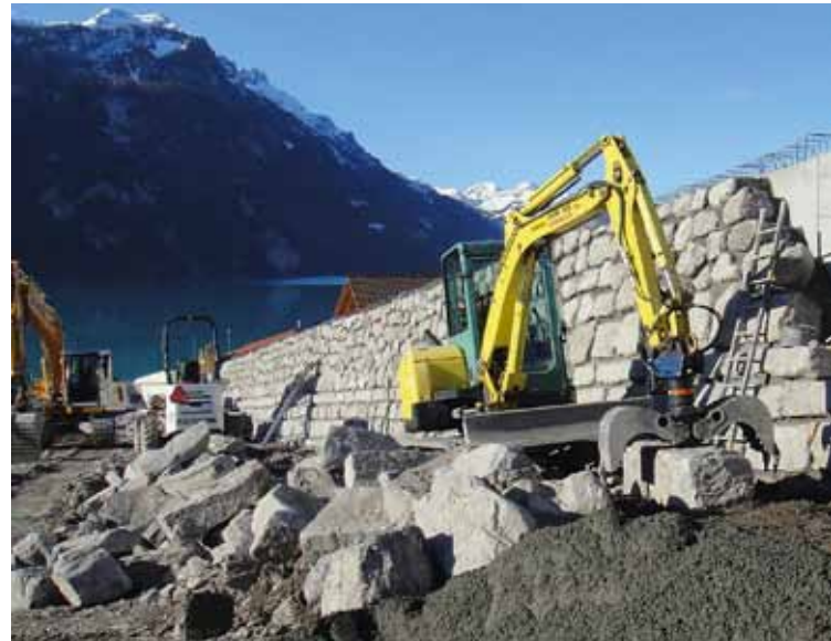
Vormauerung auf der Westseite mit Sohlensteinen aus der alten Glyssibachschale
