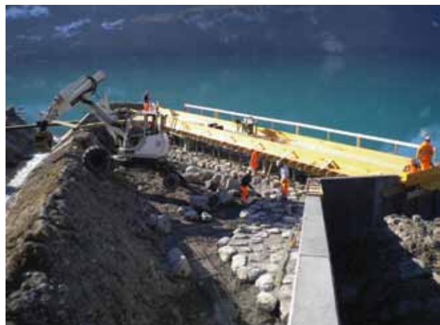
Die Blockrampe im Bau
