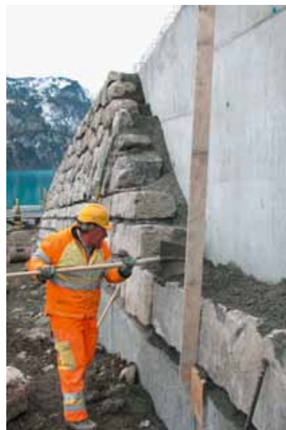
So wächst die Mauer: Zuerst bringt Mauricio Nunes da Graça Mörtel auf...
