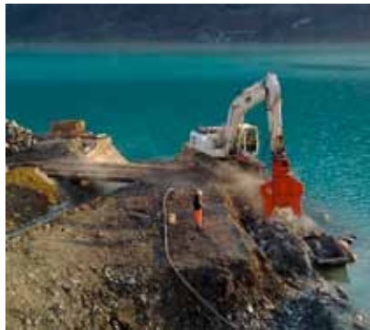
Abbruch der alten Quaimauer
