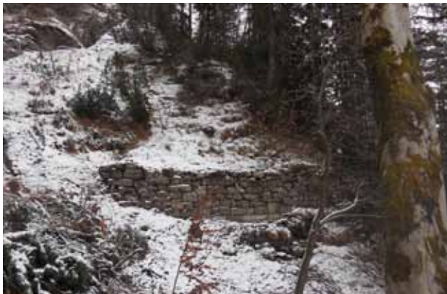
Sanierte Stützmauer im Haltiwald: Fundament und zerfallener Mittelteil ergänzt.
