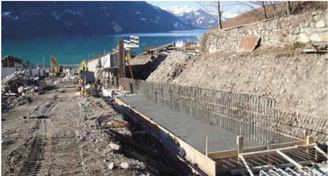
Das Fundament der Schutzmauer West wird erstellt.
