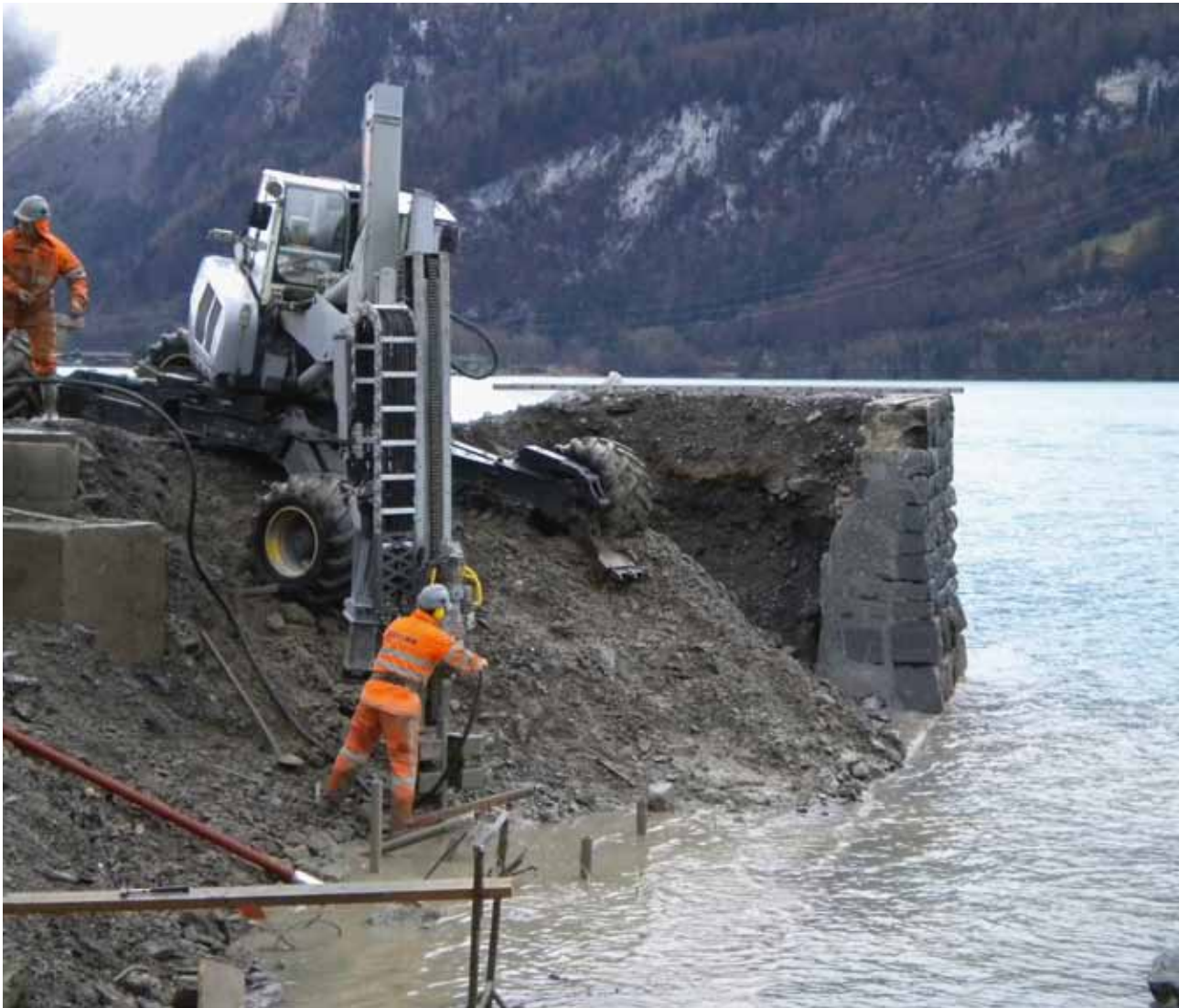
Arbeiten unter erschwerten Bedingungen: Absetzen des Pfahlbanketts am Seeufer für die Mittelpfeiler des neuen Fussgängerstegs
