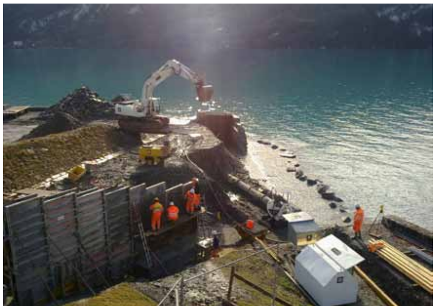
Eine der seitlichen Leitmauern des Abflusskorridors wird erstellt.
