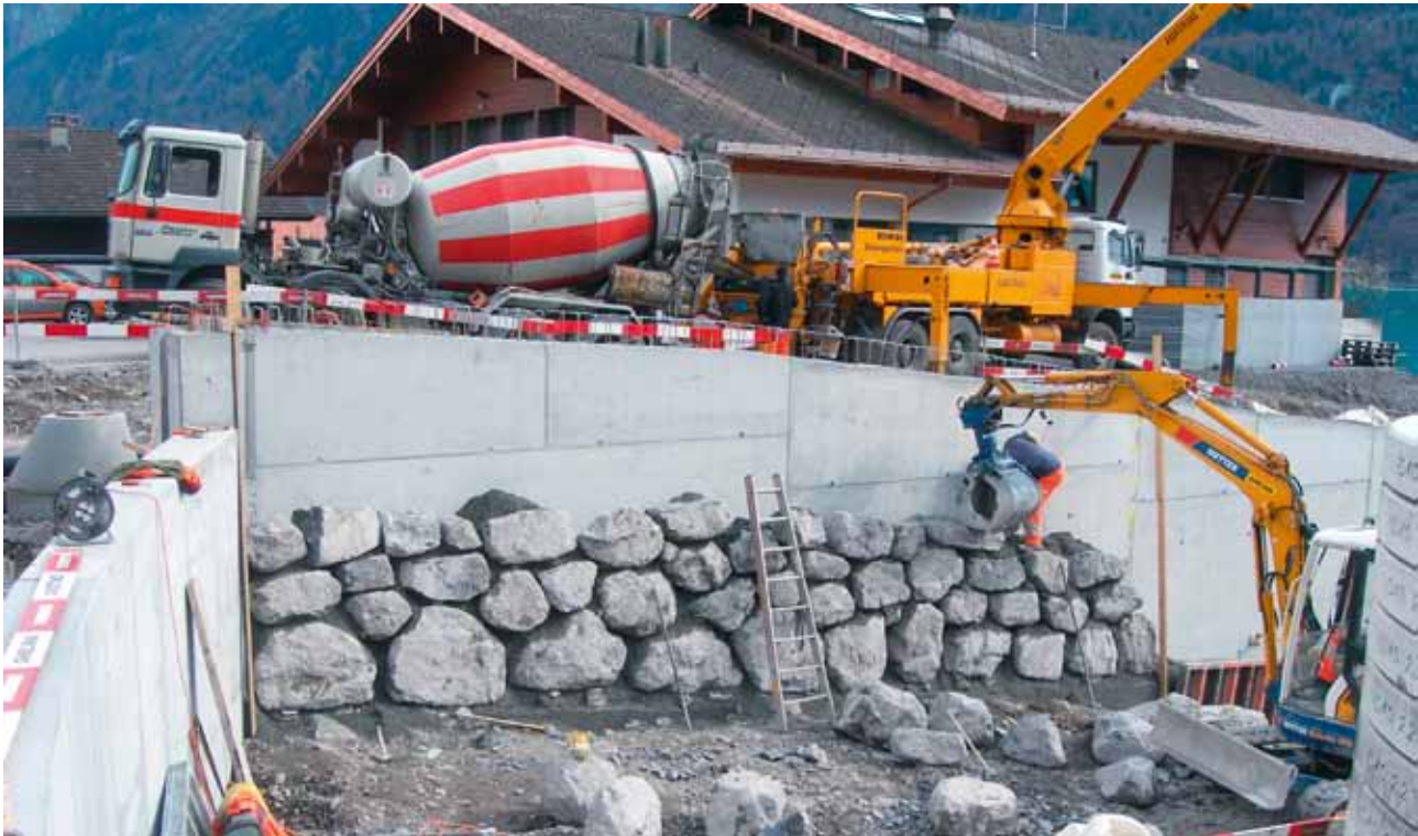
Vormauerung Schutzmauer Ost
