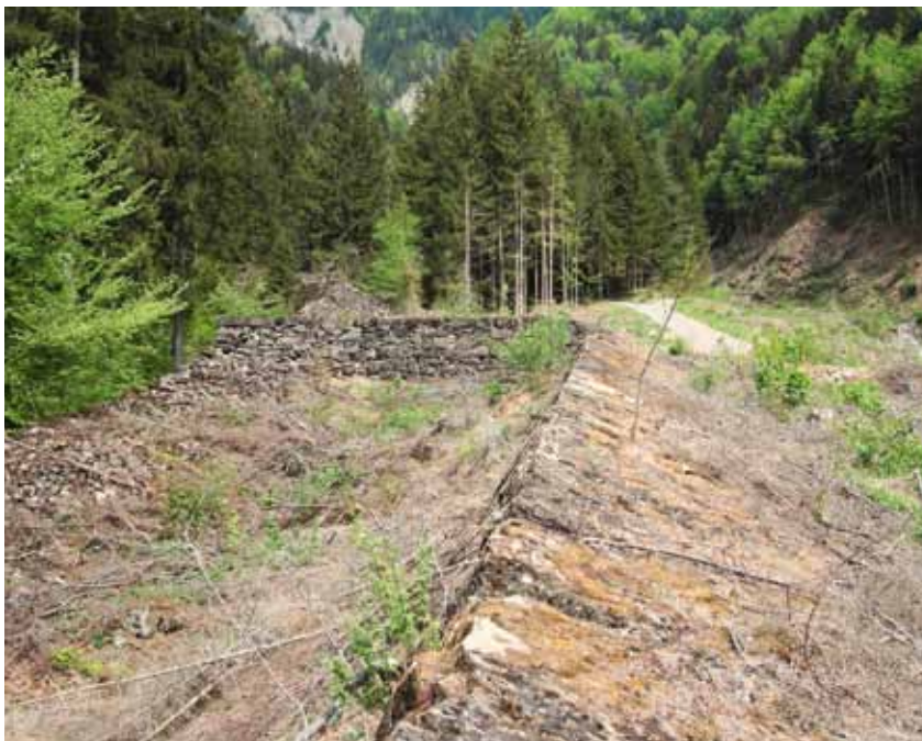
Bestehender Schutzdamm am rechten Ufer des Eistlenbachs
