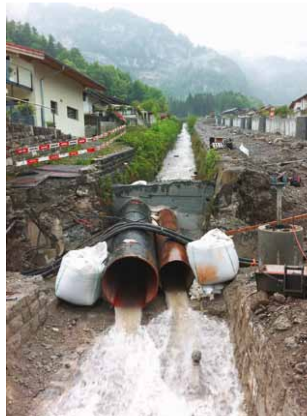
Wasserhaltung mit zwei Stahlrohren
