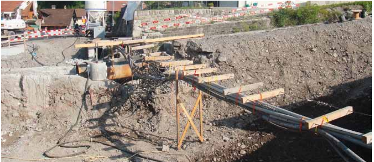
Provisorische Rohrbrücke
