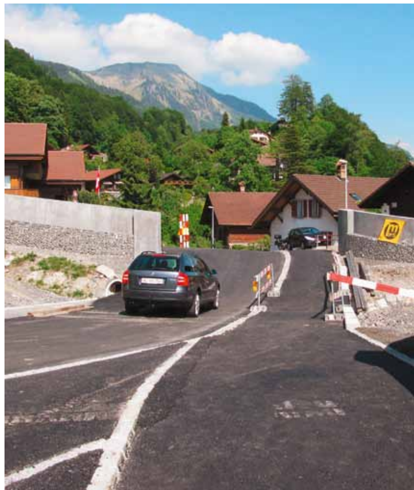
Neu eingebauter Belag an der Furt.
