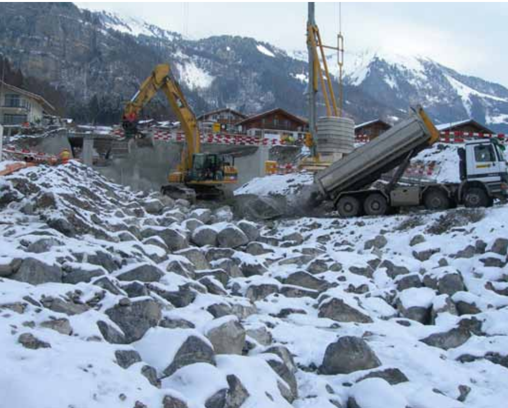
Anlieferung von Blocksteinen für den Bau des Raubettgerinnes.
