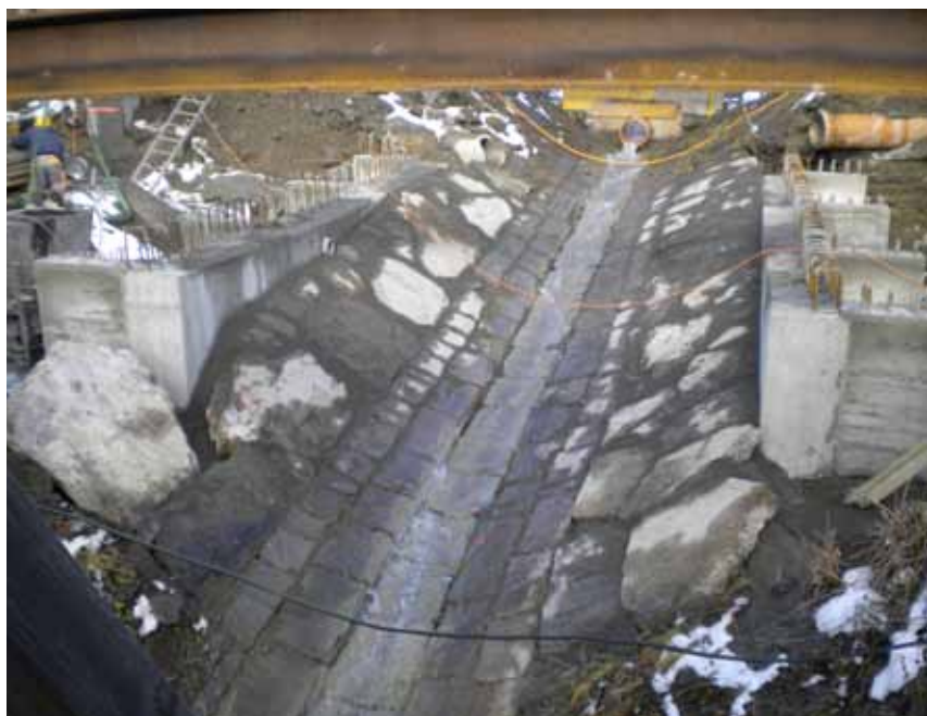
Die Widerlager sind erstellt und das Gerinne wieder instandgesetzt.
