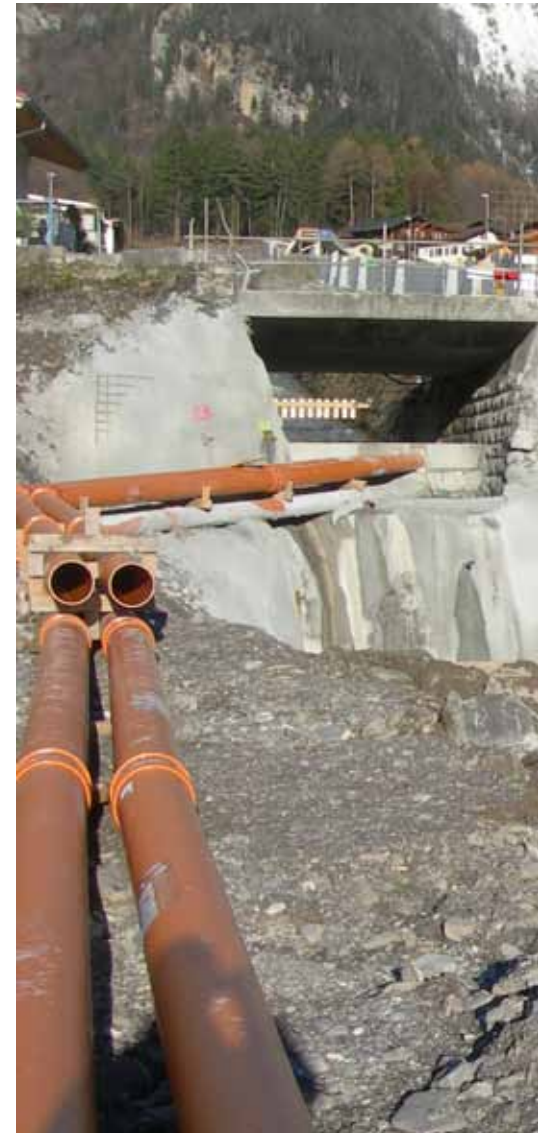
Baugrube südlich der Kantonsstrasse für den Bau der neuen Brücke.
