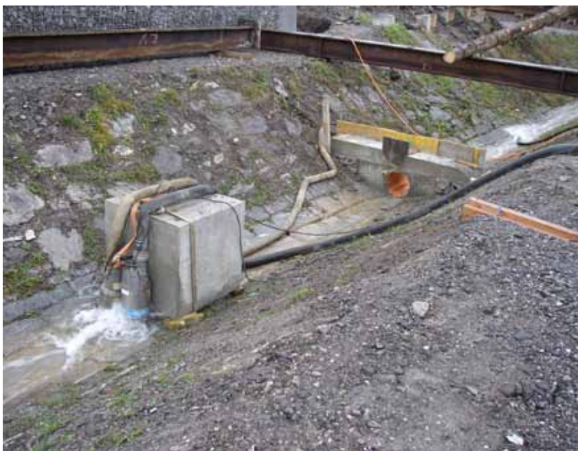
Zum Schutz der Wasserhaltung wurde ein massiver Betonklotz im Gerinne platziert.
