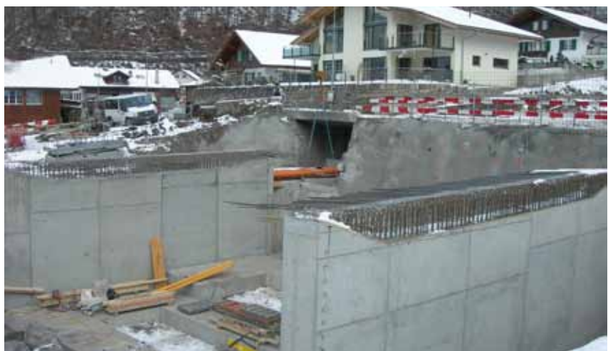
Widerlager der neuen Kantonsstrassenbrücke.
