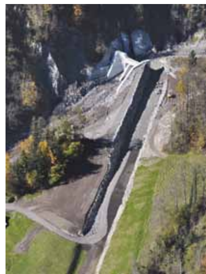
«Luftbild» von der Schwanderfluh aus: Das Ausleitbauwerk mit dem Überleitgerinne
