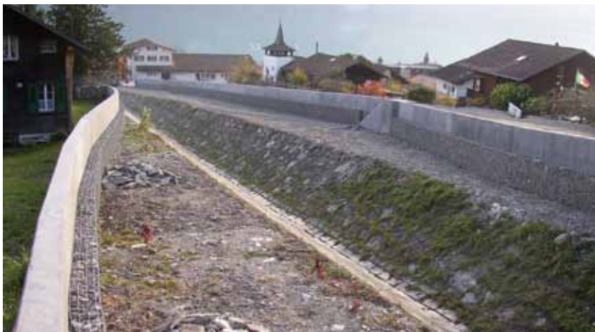
Leitmauern mit Steinkörben, neuer Wanderweg und Steinlinsen für Reptilien.
