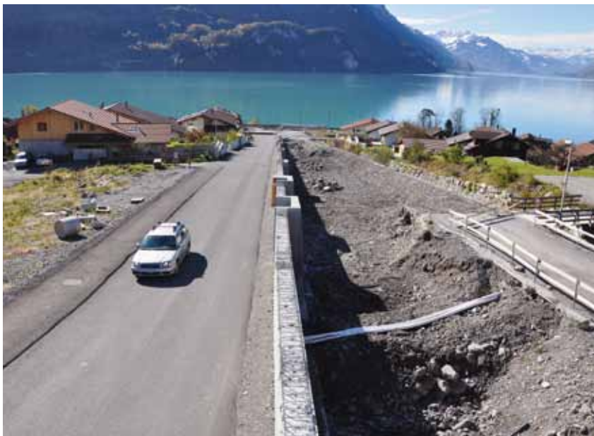
Blick von der Gehwegrampe auf die neue Schwanderstrasse und zum See.
