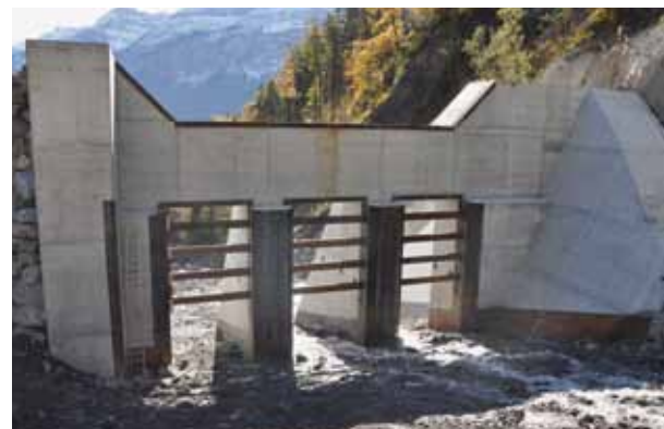
Das fertig gestellte Ausleitbauwerk von Norden gesehen.
