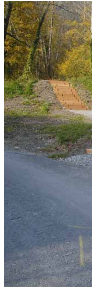
Mit Steinkörben geschlossene Uferlücke auf der rechten Bachseite und neu angelegter Wanderwegabschnitt.
