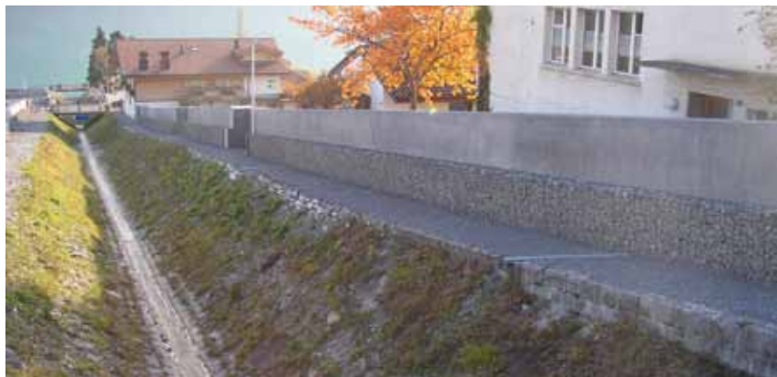
Leitmauer mit Steinkörben und Gestaltungsnischen, neuer Wanderweg entlang dem Trachtbach.
