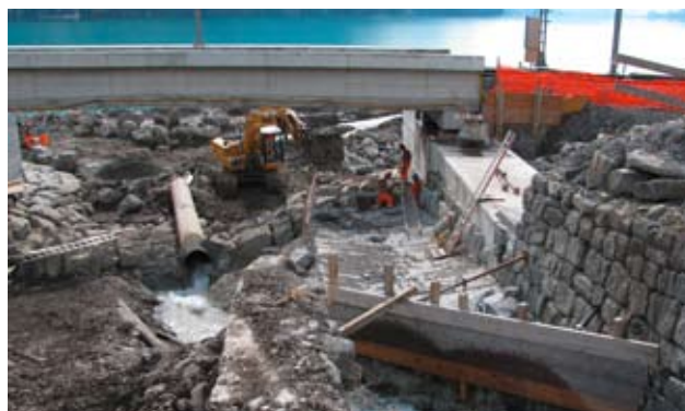
Versetzen der Blöcke für das Raubettgerinne mit der Baggerzange
