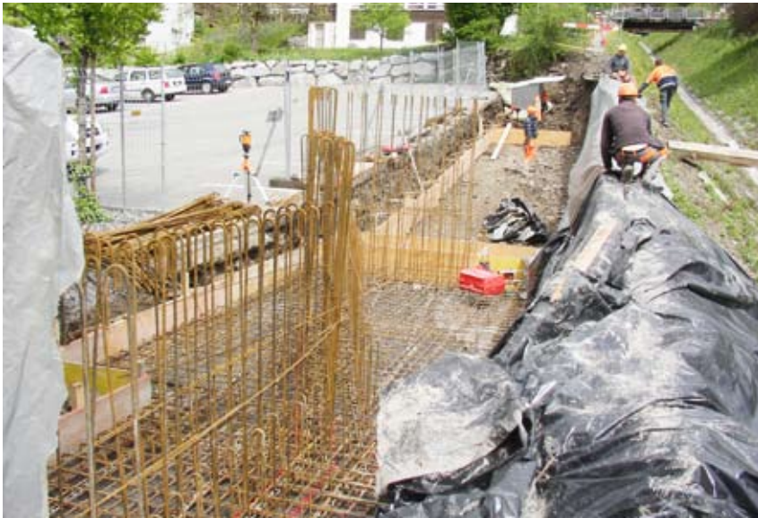
Beim Erstellen der neuen Schutzmauern wurde darauf geachtet, dass die bestehende Gerinneschale nicht beschädigt wird.
