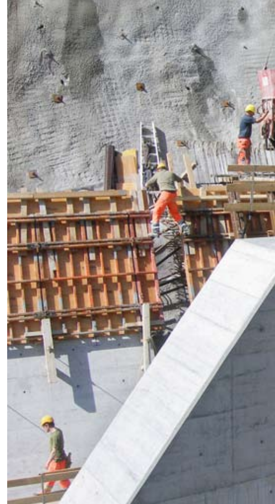
Betonarbeiten an der Westwand des Ausleitbauwerks.
