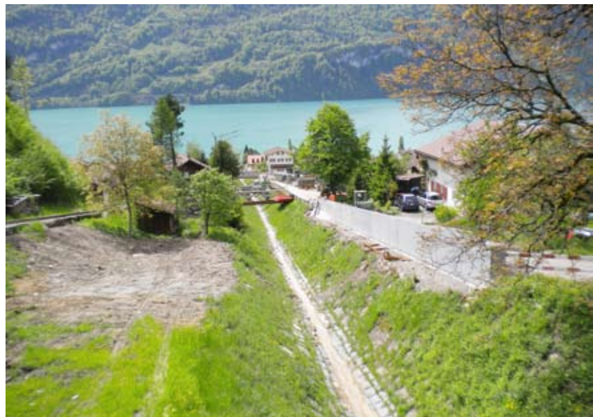
Die Leitmauer auf der rechten Bachseite entlang des Steineggliweges ist bereits bis zum Lauelliweg erstellt.
