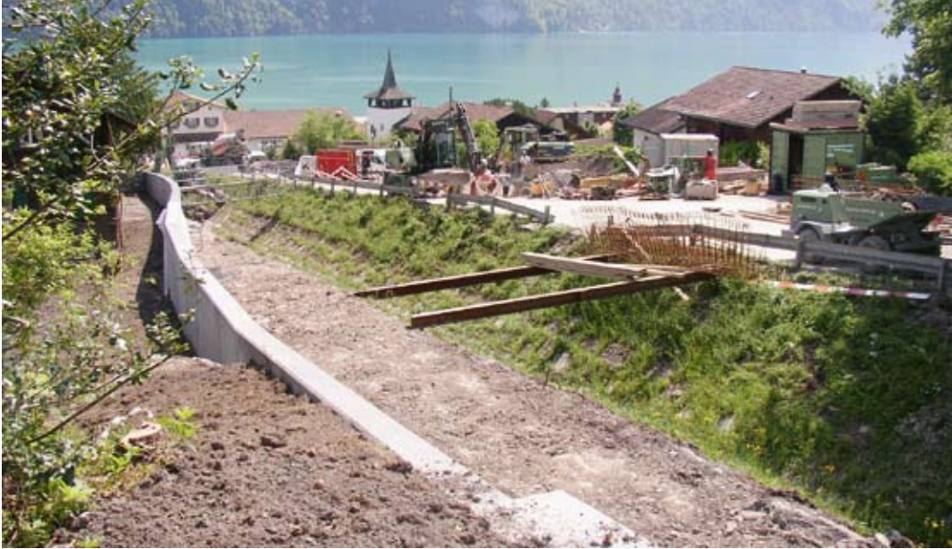
Ein Stück der neuen Leitmauer auf der linken Bachseite, kurz vor Baubeginn am Steineggliweg.
