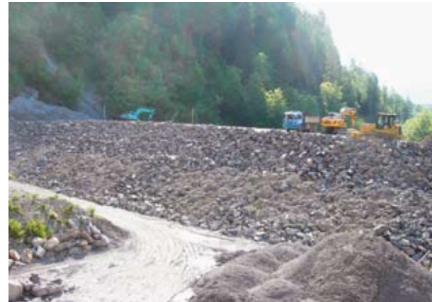
Die Bergseite des Schutzdamms ist mit Schropfensteinen belegt.
