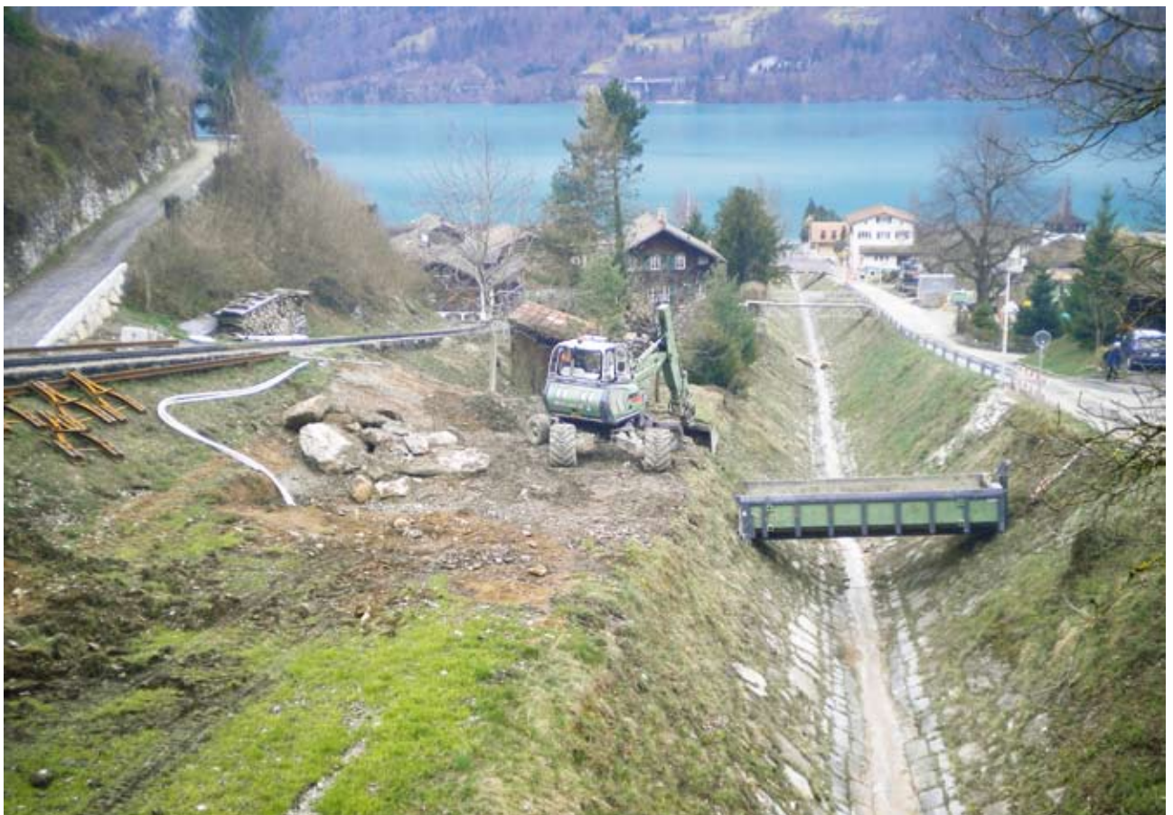
Blick von der Lehrerbrücke auf das Bachbett des Trachtbachs kurz nach Baubeginn im März 2010.
