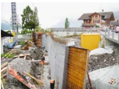
Die Stützmauer unterhalb der Kantonsstrasse im Bau.
