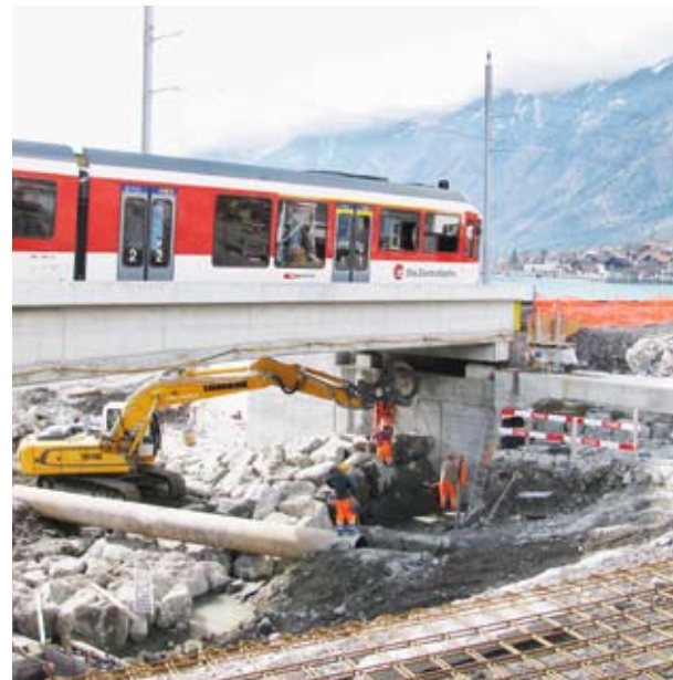
Das Raubettgerinne unterhalb der Brücke der Zentralbahn wird erstellt.
