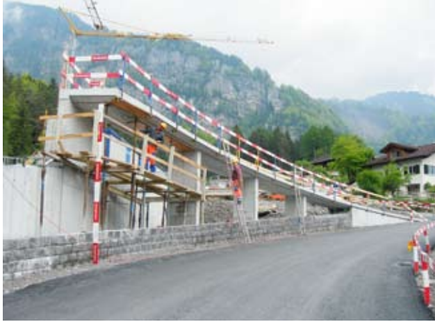
Links: Die neue Schwanderstrasse mit der Gehwegrampe (später der Zugang von der Schwander Seite zur Fussgängerbrücke).
