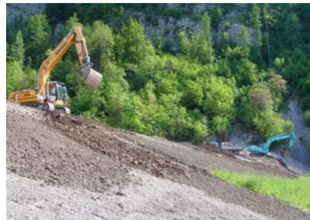
Auf der Talseite des Schutzdamms wird Humus ausgebracht.
